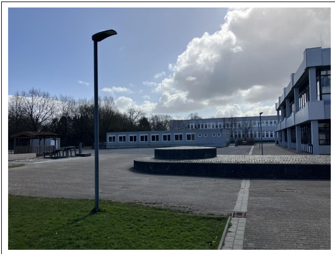
Foto Nr. 3 Schulhoffläche mit vorh. Containeranlage
